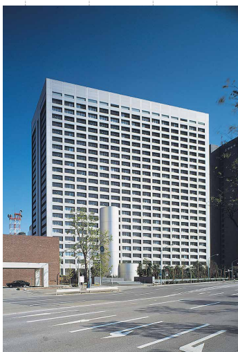
1976 ●三井物産本社ビル
