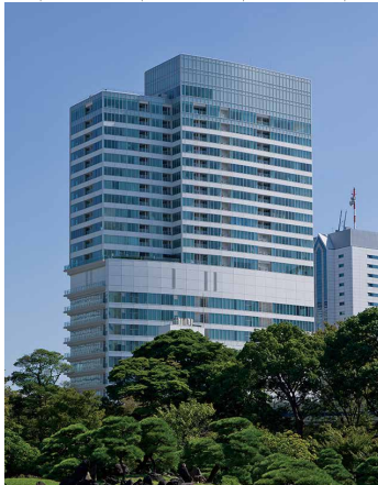
2011 ●浜離宮インターシティ
