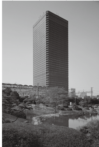
1970 ●世界貿易センタービル
